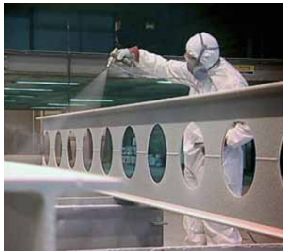
Aplicação na viga
